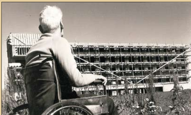
Hús Sjálfsbjargar í byggingu og væntanlegur íbúi fylgist með. Framkvæmdir hófust við byggingu hússins árið 1966. Uppsteypu var lokið við fyrsta áfanga árið 1968. Árið 1973 fluttu fyrstu íbúarnir inn.
